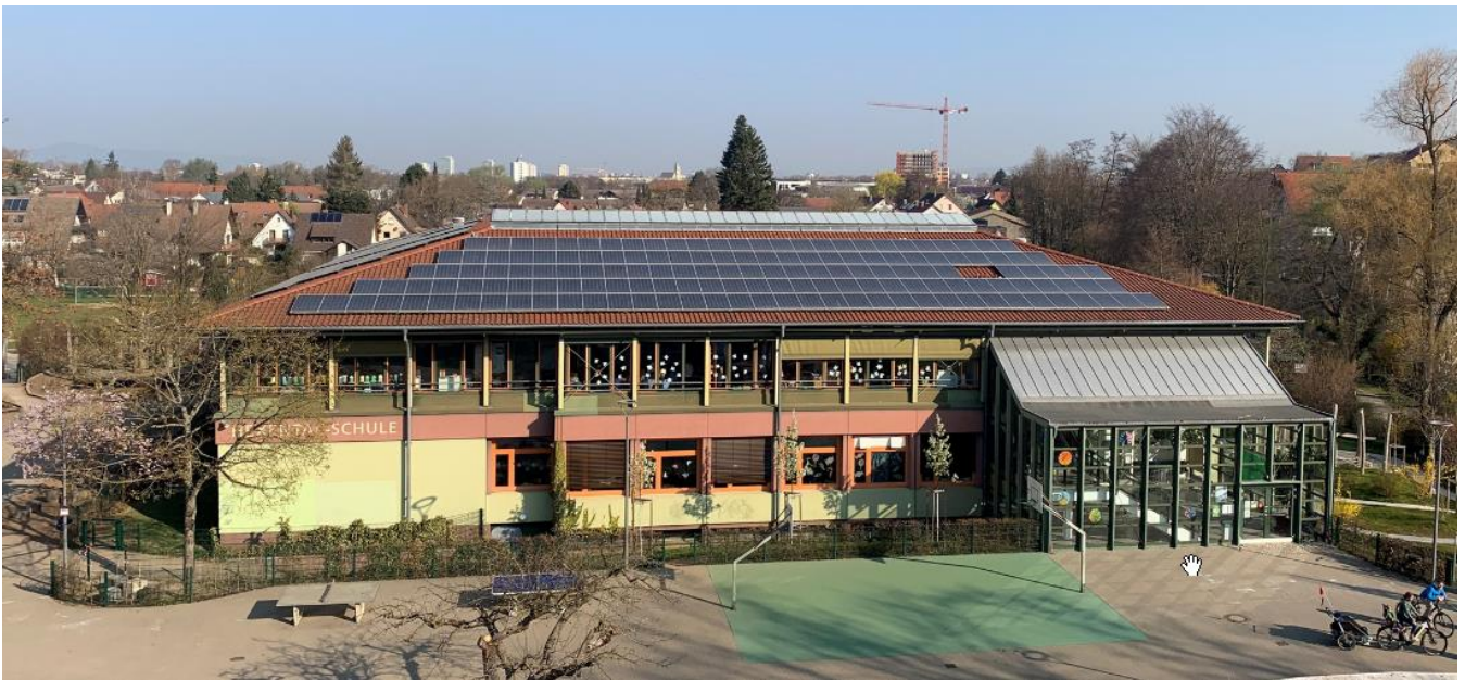
Das Land stellt Mittel zur Sanierung des Alois-Rapp-Hauses (Hexentalschule) zur Verfügung.
